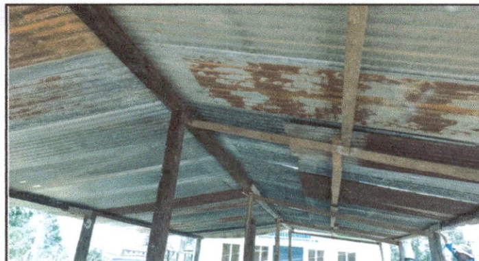
Foto 3: Se sustituye la estructura de madera, por estructura de metal.
