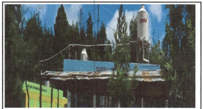
Foto 4: Se sustituyen estructura de madera, por estructura de metal.
