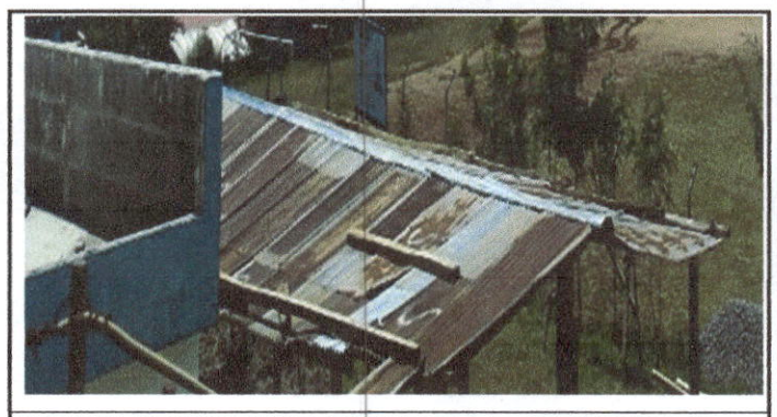
Foto 6: Se sustituyen la Estructura de madera, por estructura de metal.
