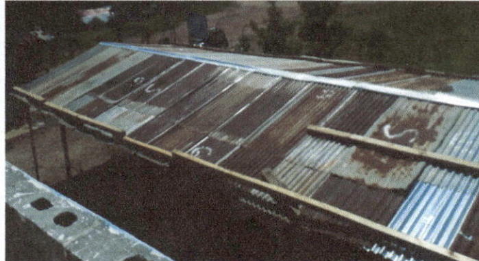
Foto1: Se sustituye lámina deteriorada, por lámina troquelada, alum zinc calibre 26.
